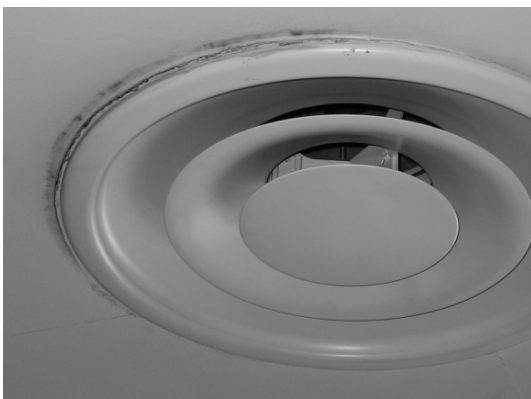
図5. 天井が歪みずれた給気ダクト (左) と装置に積った天井から降下した塵 (測定室)
