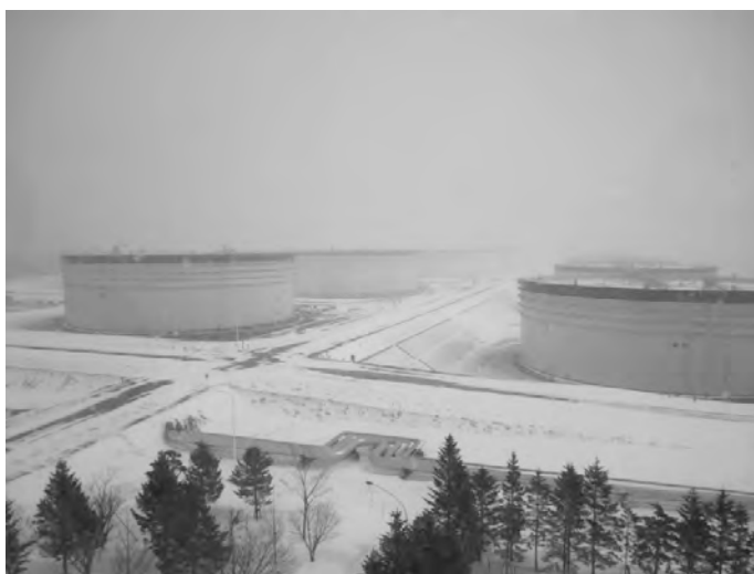
写真 2. むつ小川原国家石油備蓄基地、展望室からの眺め
