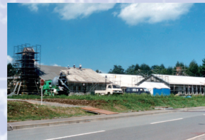
写真 1. 建設中の NMCC
