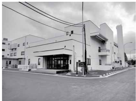
改修後のサイクロトロン実験棟
